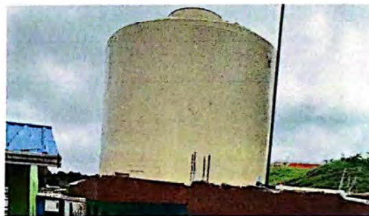
Foto 10: Sustitución de Rotoplas
