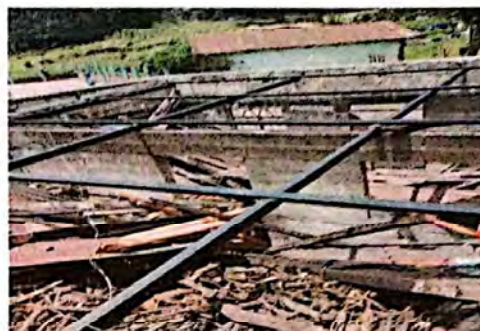
Foto 2: Sustrucción de estructura de madera a metal
