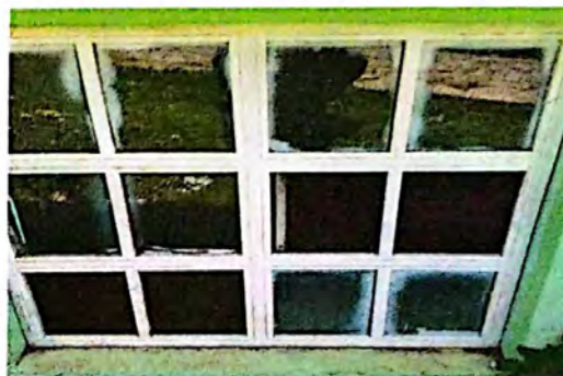
Foto 4: Sustrucción de ventanas de metal y vidrios
