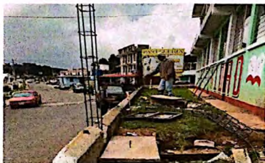
Foto 9: Sustitución de baranda de metal
