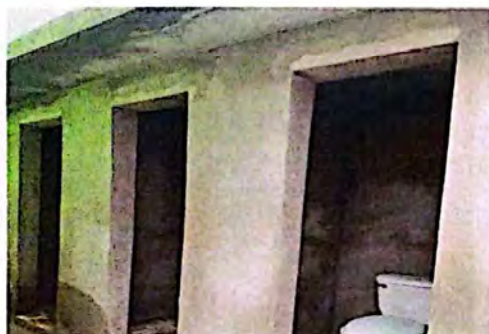
Foto 3: Sustrucción de puertas
