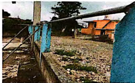
Foto 8: Sustitución de maya
