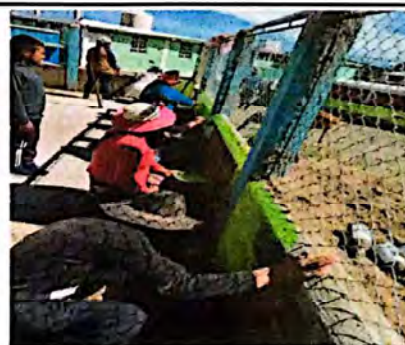
Foto 6: Pintura de muros exteriores e interiores
