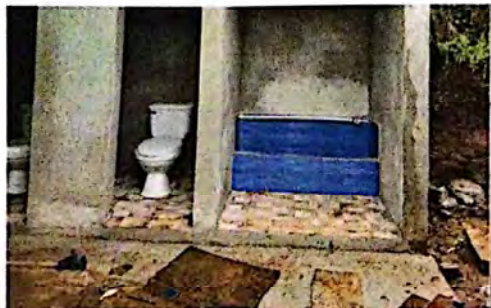
Foto 7: Sustitución de Sanitarios
